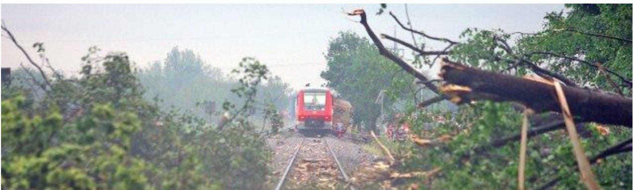
Baumreste auf Regionalbahnstrecke bei Baienfurt
