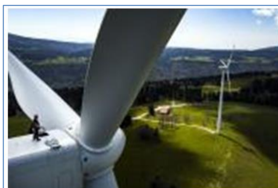
Ein Arbeiter steht auf einer 150 Meter hohen Windturbine in Saint-Imier auf dem Mont-Soleil. (Bild: Keystone)
