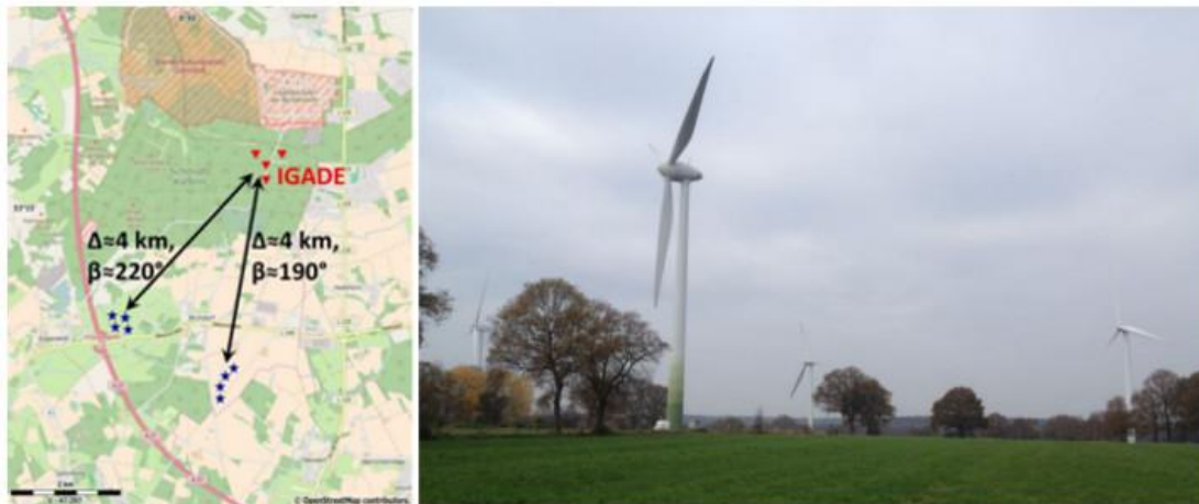
Abbildung 2: Windkraftanlagen (hier: vier Enercon 1800 kW südwestlich von IGADE, in Betrieb seit 2005) in 4 km Umkreis zum Infrасhall-Array IGADE nördlich von Bremen. Vier weitere Anlagen in südlicher Richtung wurden 2006 errichtet Quelle: BGR
