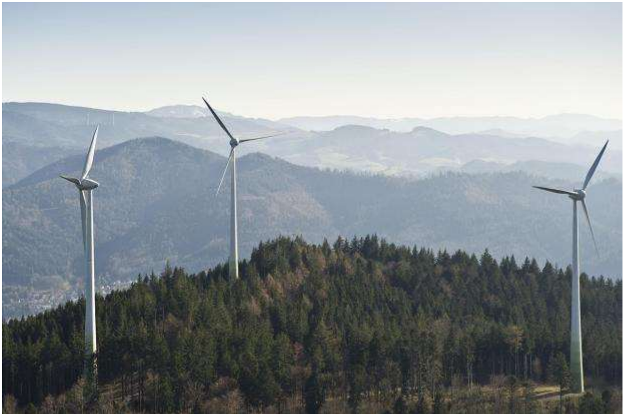
30.000 Windenergieanlagen drehen sich in Deutschland, hier am Rosskopf, Freiburg im Breisgau
