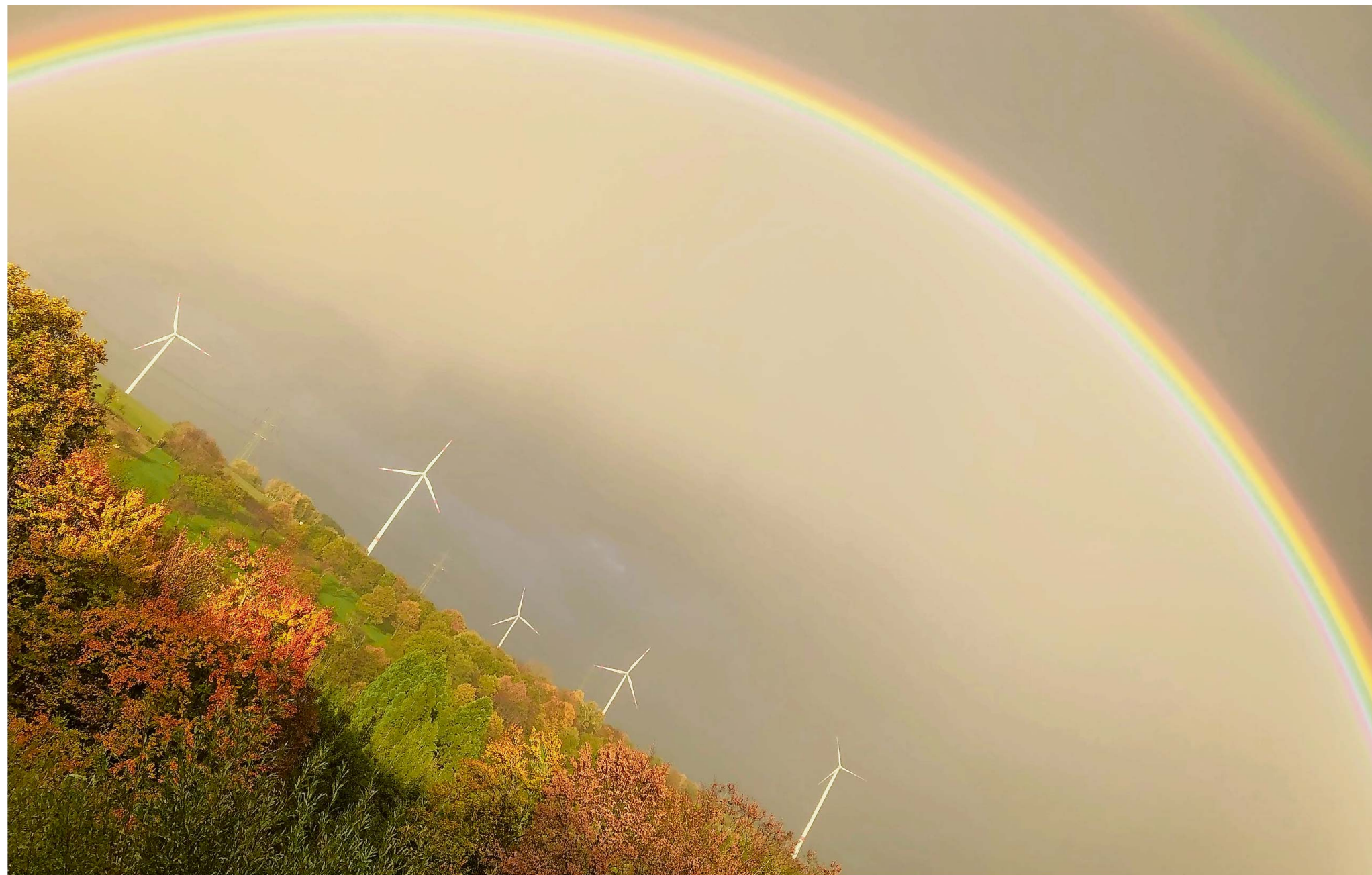
Der Windpark Schiffweiler auf dem Strietberg wirkt unterm Regenbogen geradezu idyllisch. Für die Greifvögel, die dort brüten, können die Rotorenblätter zur tödlichen Gefahr werden.
